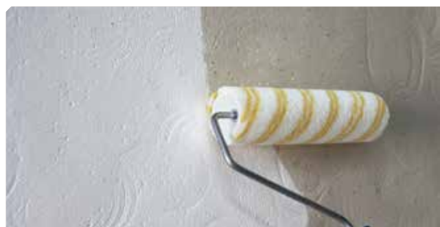
■ Imprimitura del supporto con il consolidante
